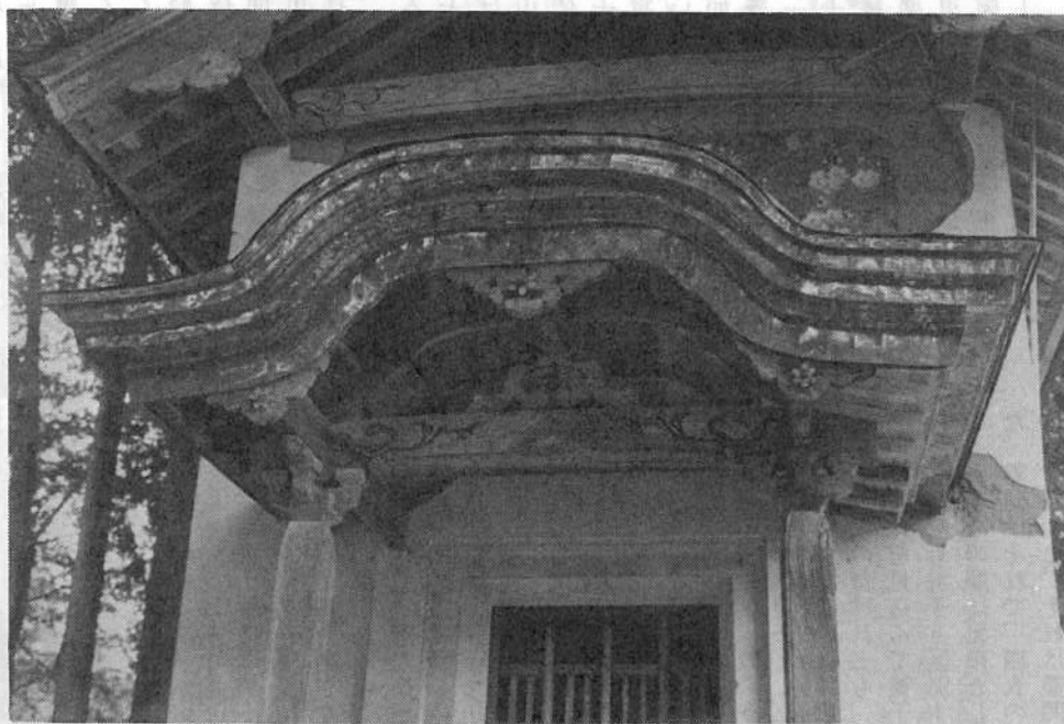
修復なった経蔵の屋根
