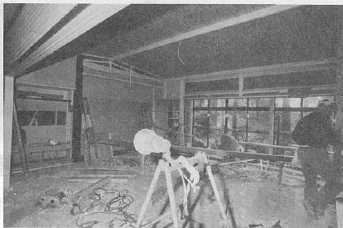
▲新築の奥座敷「空華殿」
