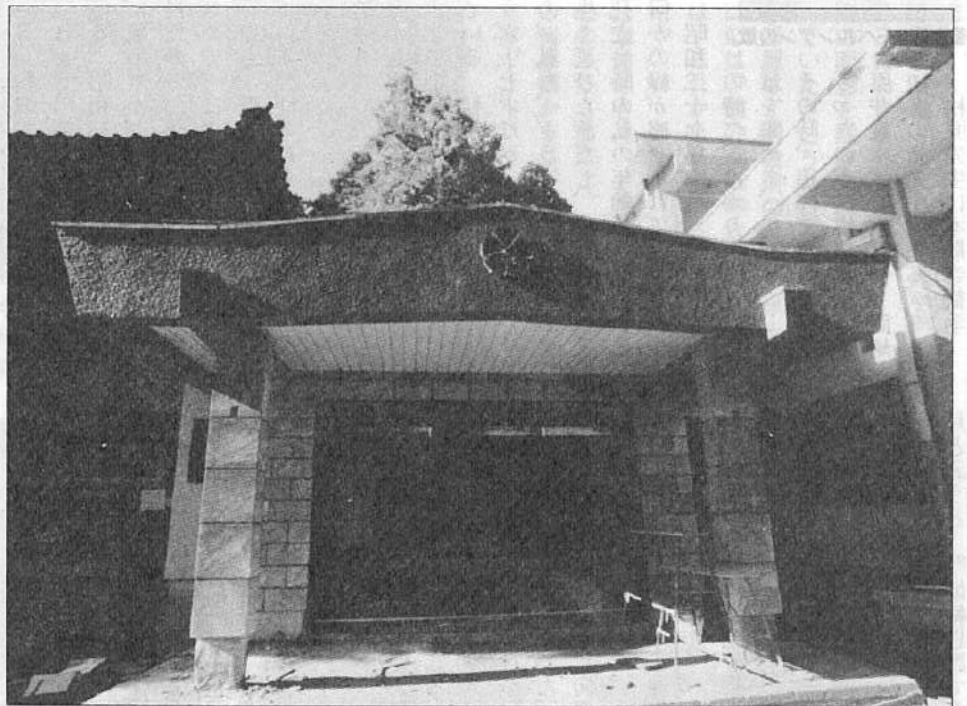
三法要記念建設事業の完成も間近。写真は仕上げを急ぐ正面玄関。
