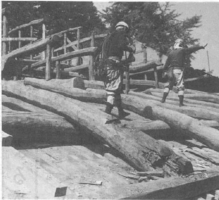
田屋解体で各所のいたみが……
