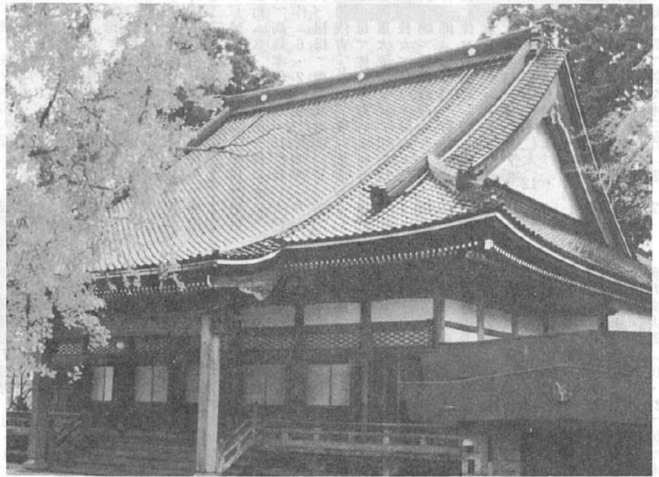
修復なった善巧寺本堂の大屋根
