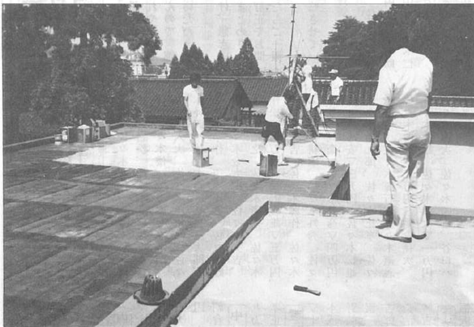
庫裡屋上の防水工事 (60年7月)
