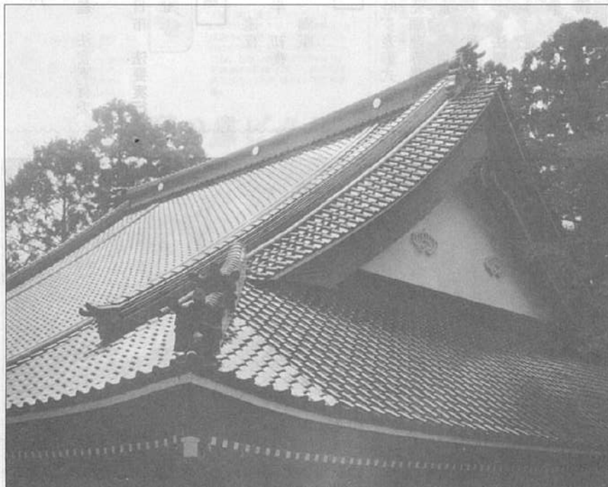
本堂大屋根修復工事 (59年10月10日完成)
