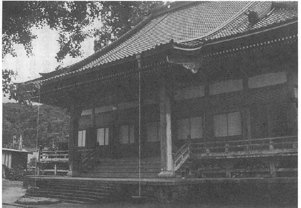
ステンレスに修繕された雨どい
