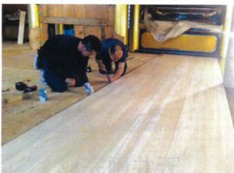
6/21 内陣中央は構造合板の上にヒノキ板
