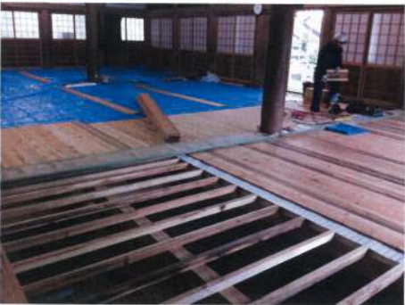
5/18 ハウスラップの上に板張り
