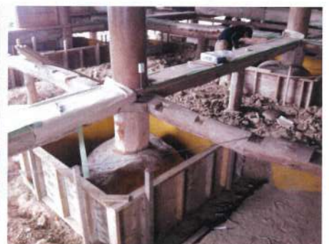
4/30 柱の枠にコンクリを流します。
