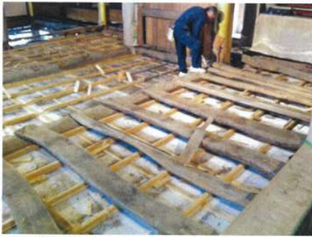
4/9 内陣の床板外し
