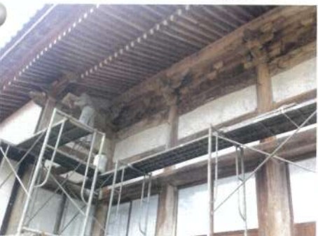
6/30 白壁は下地に漆喰塗り
