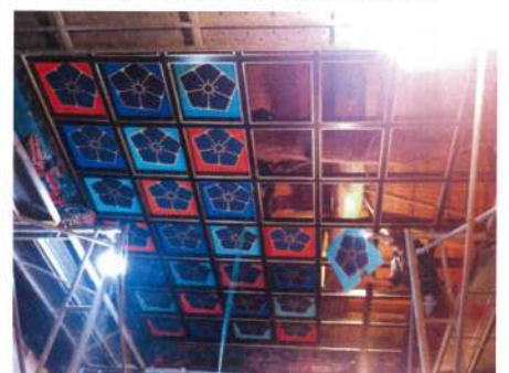
6/20 天井画の貼り付け
