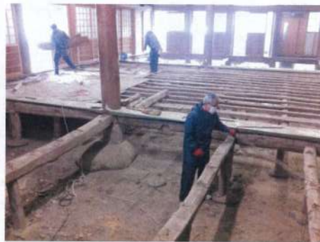
4/10 外陣の床板外し
