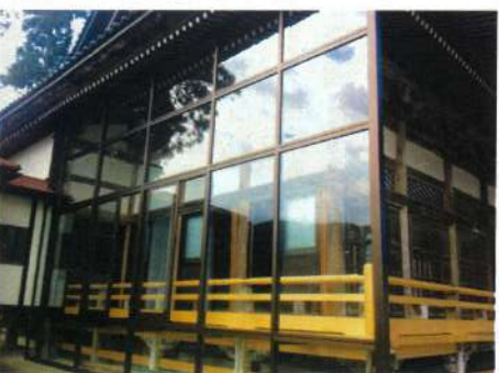
山側に風除設備が取り付けられました。
