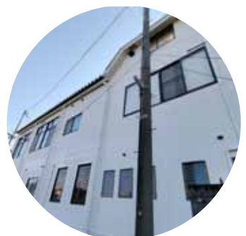
門徒会館外壁
